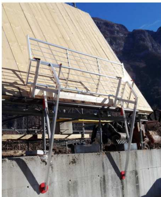
Figura 21: Immagine dell'installazione per il TEST N°2
